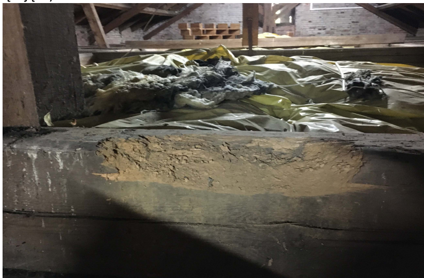
Fot.1. Korozja belki spinającej.
