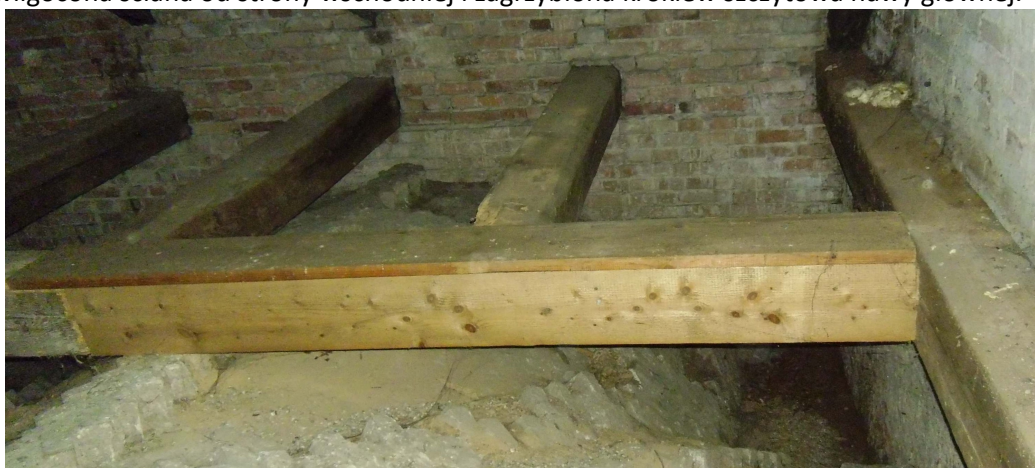
Fot.5. Istniejące naprawy elementu uszkodzonego.
