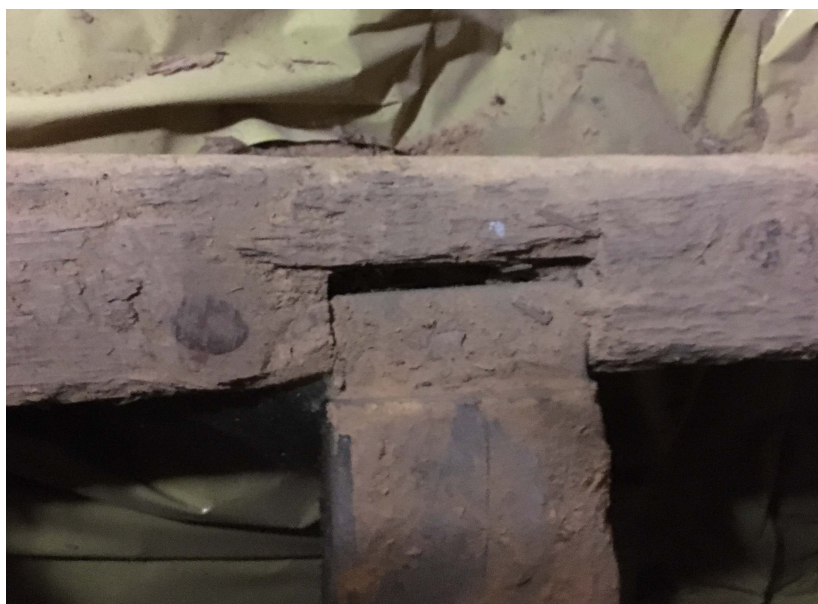
Fot.2. Korozja belki spinającej rozluźnienie zamka.
