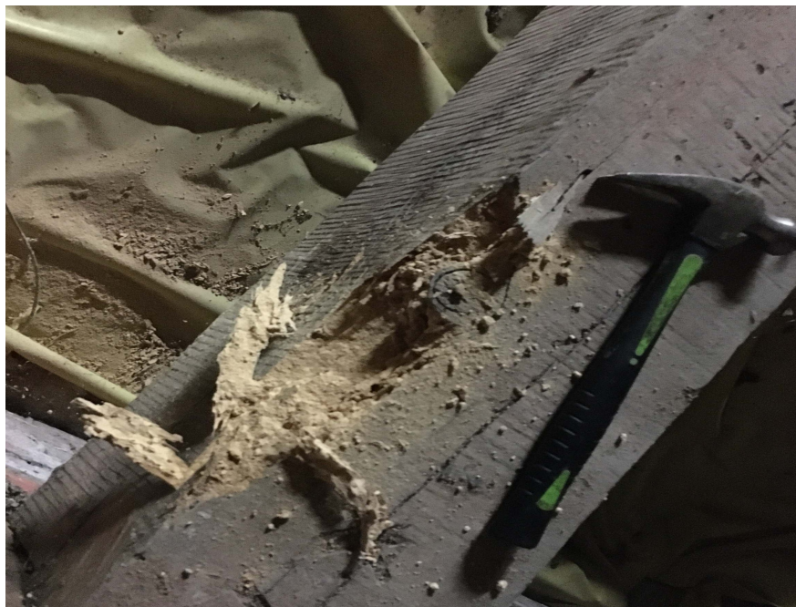
Fot.3. Odkrywka skorodowanej belki przy otworach wylotowych owadów technicznych szkodników drewna.
