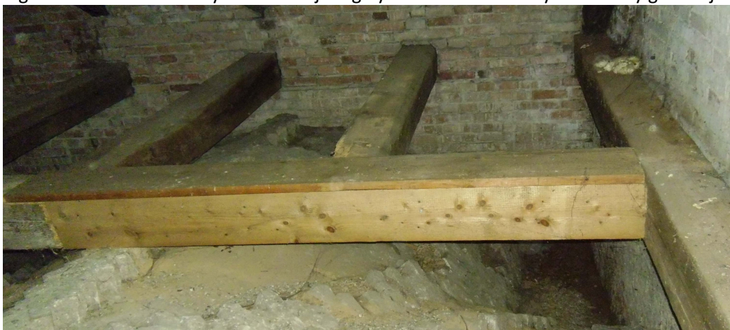
Fot.5. Istniejące naprawy elementu uszkodzonego.
