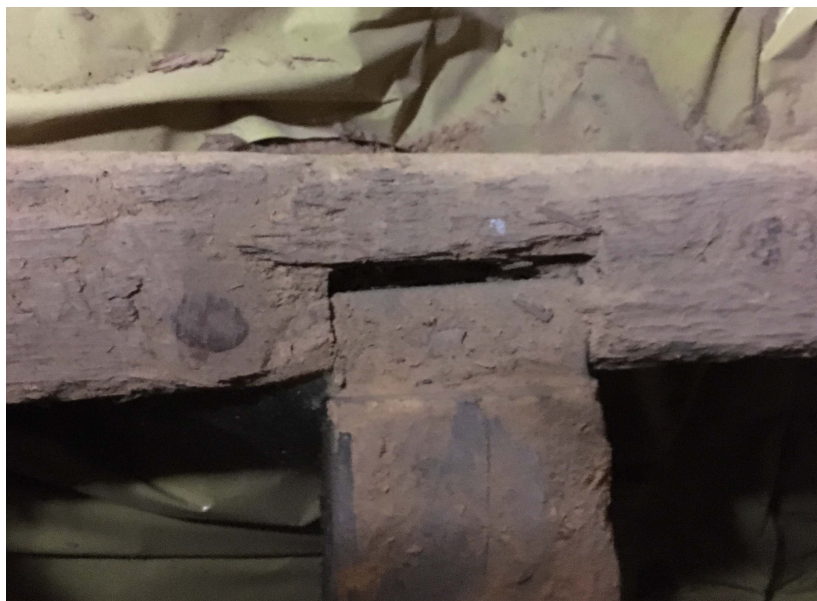
Fot.2. Korozja belki spinającej rozluźnienie zamka.
