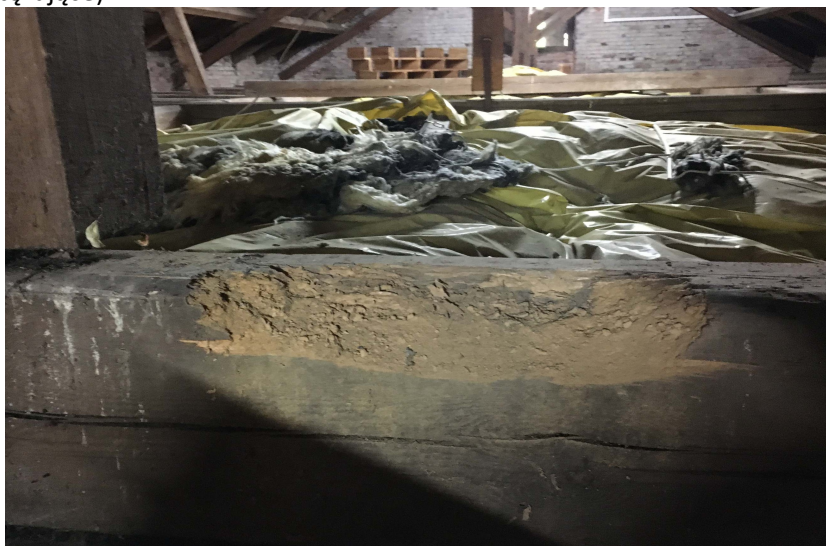
Fot.1. Korozja belki spinającej.
