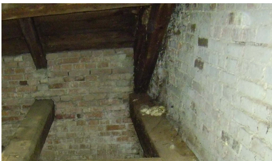
Fot.3. Odkrywka skorodowanej belki przy otworach wylotowych owadów technicznych szkodników drewna.
