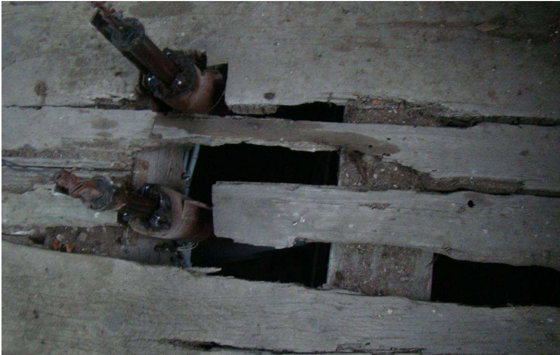
Fotografia.13. Dzwonnica - poszycie deskowe stropu – ubytki
