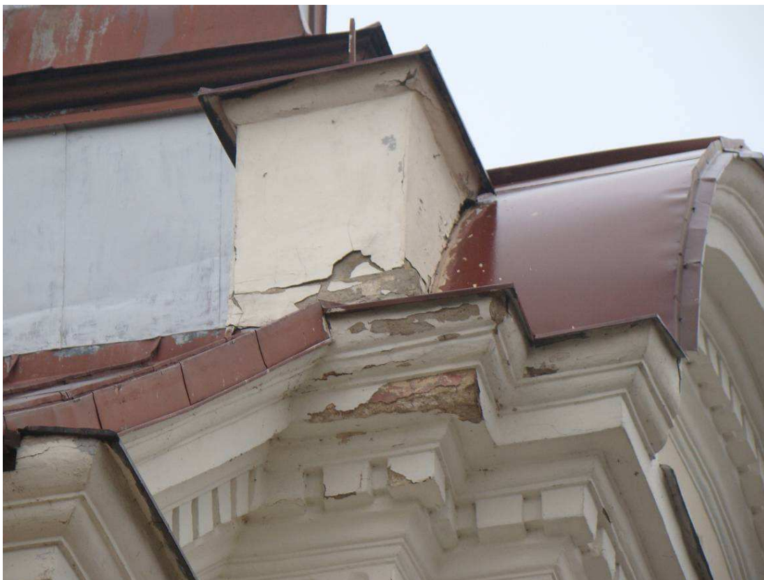
Fotografia.7. Ubytki gzymsu.
