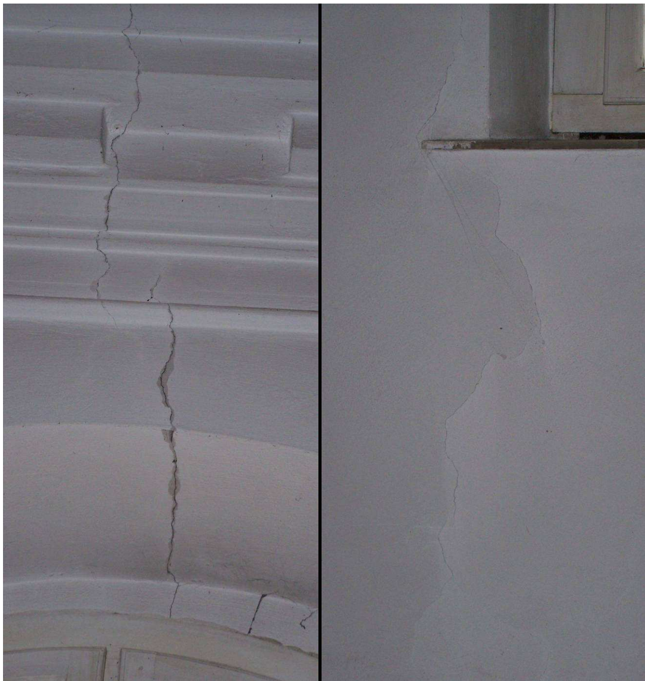
Fotografia.10. Rysy pionowe ścian – widok od wewnątrz
