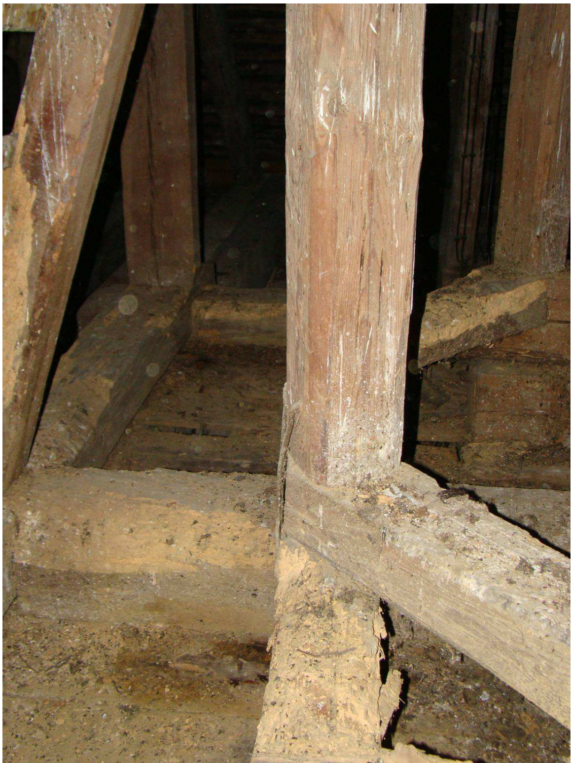
Fotografia.4. Więźba dachowa pod wieżą – korozja belek
