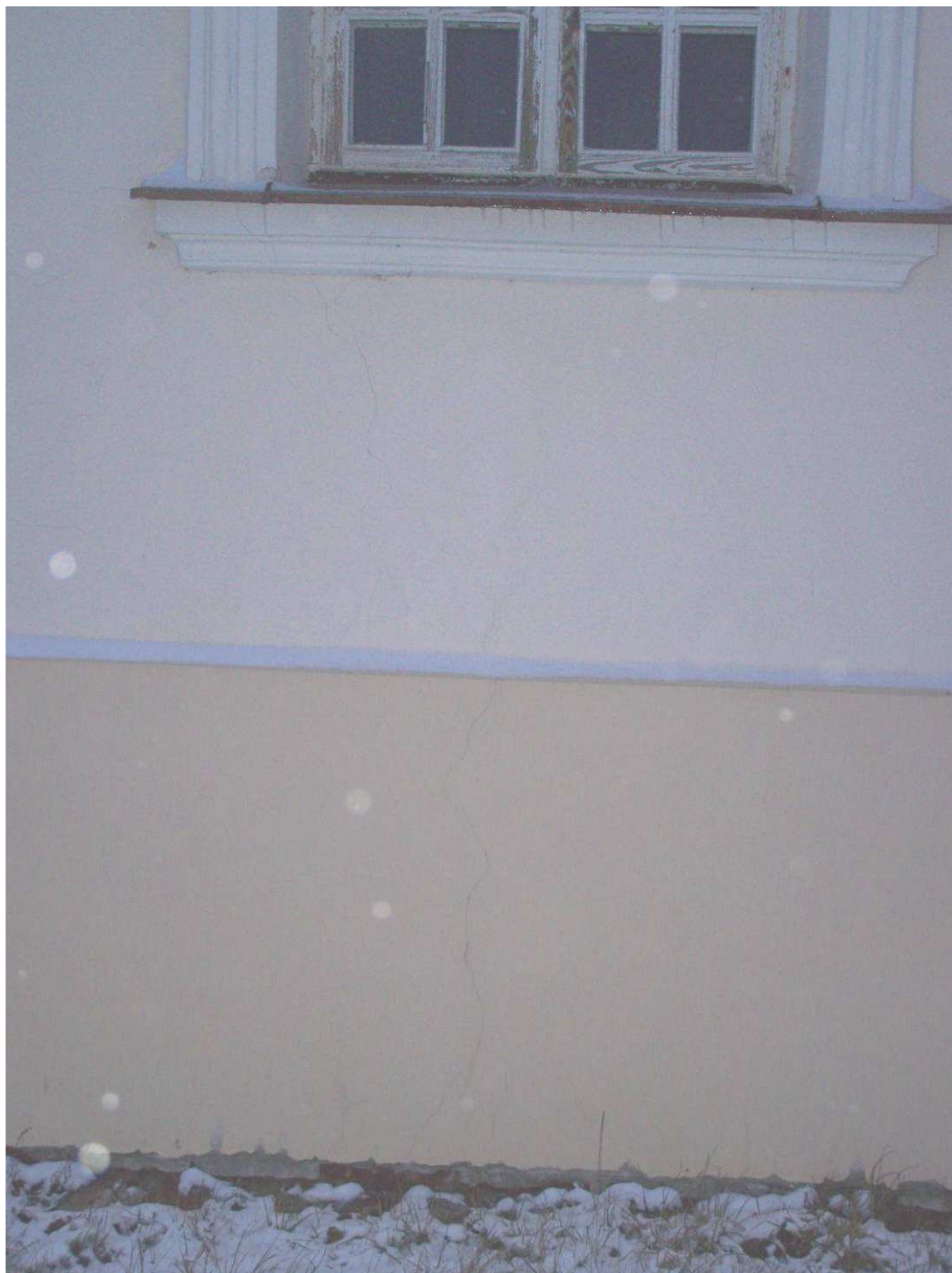
Fotografia.9. Rysy pionowe ścian
