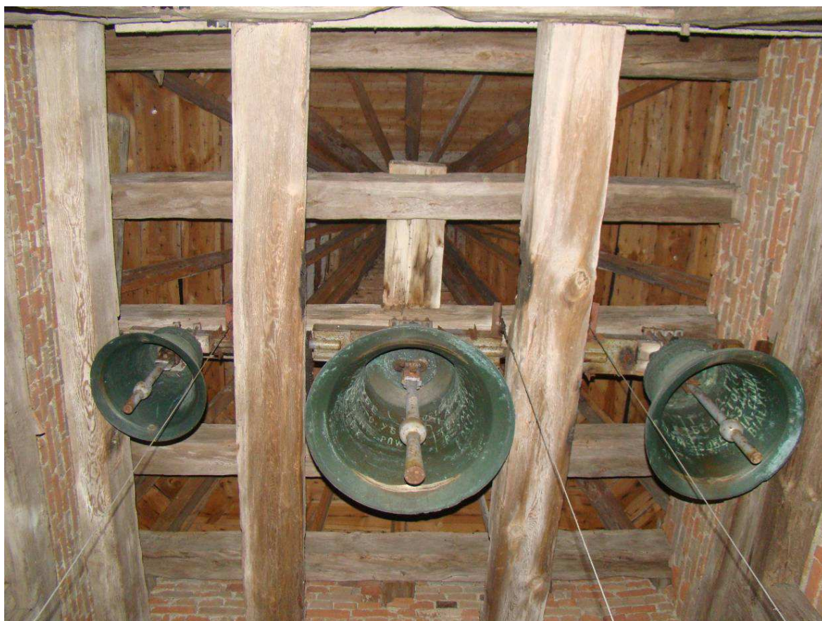
Fotografia.12. Dzwonnica – więźba dachowa, konstrukcja wsporcza dzwonów
