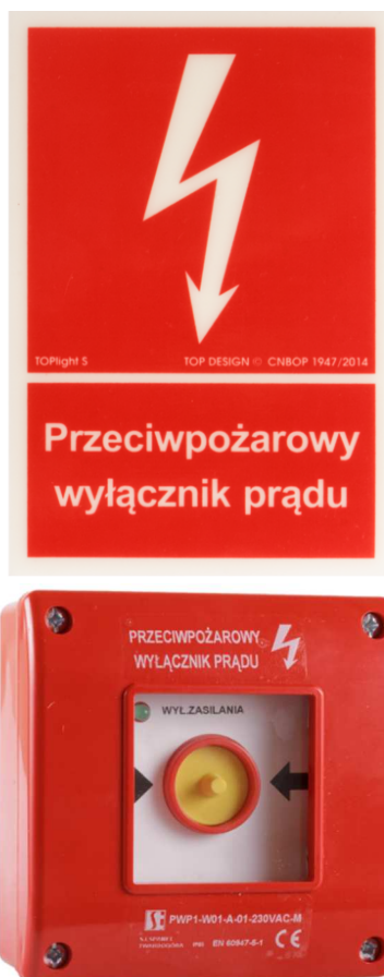
Rysunek 1. Oznaczenie elementu sterujacego (przycisk PPOŻ) znakiem „Przeciwpowozarowy wylacznik pradu”.
